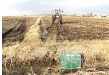
弾丸暗渠施工状況
