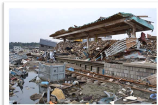
津波により被災した南気仙沼駅 【JR気仙沼線・気仙沼市 5/11撮影】
