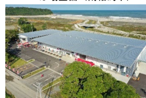
甘藷貯蔵施設（楢葉町）
