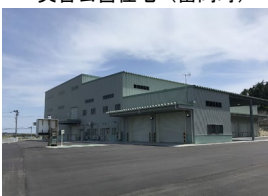
カントリーエレベーター（南相馬市）
