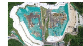
特定廃棄物埋立処分場
