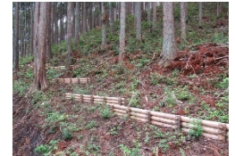
移動抑制対策(筋工)
