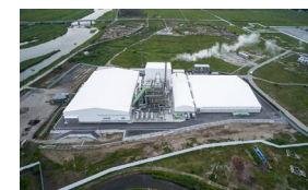
浪江町 仮設焼却施設
