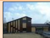
野蒜駅(新駅舎)
