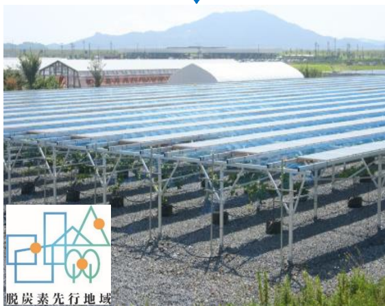
果樹栽培に最適化した営農型太陽光発電設備整備 (陸前高田市)
