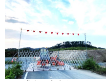
盛土工事中(R5.9)
