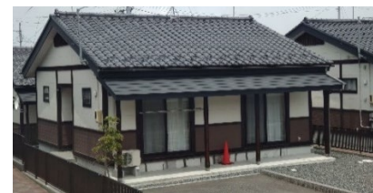
相馬市細田東団地災害公営住宅
