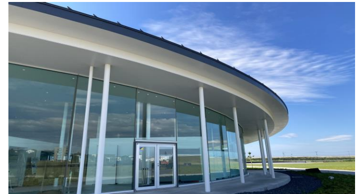
みやぎ東日本大震災津波伝承館
