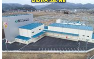
営農再開に向けた 施設整備
