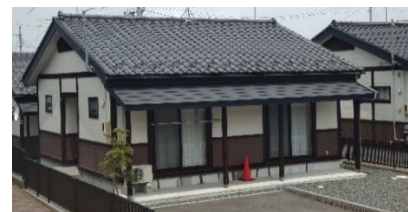
相馬市細田東団地災害公営住宅
