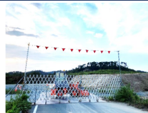
盛土工事中(R5.9)
