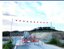
盛土工事中(R5.9)
