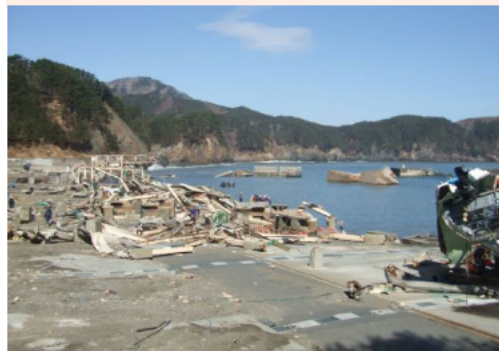
(音部漁港(宮古市))被災直後
