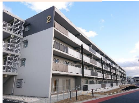
(盛岡市) 南青山アパート 内陸避難者向け 99戸一部4階建て
