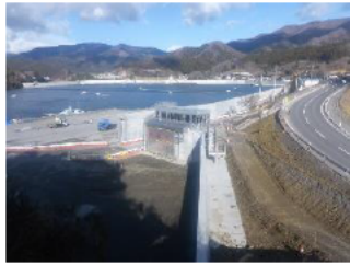
【永浜地区防潮堤】
