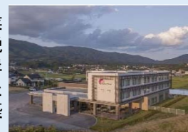
宿泊施設外観 (陸前高田市)
