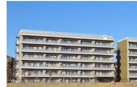
災害公営住宅 (宮城県石巻市)
