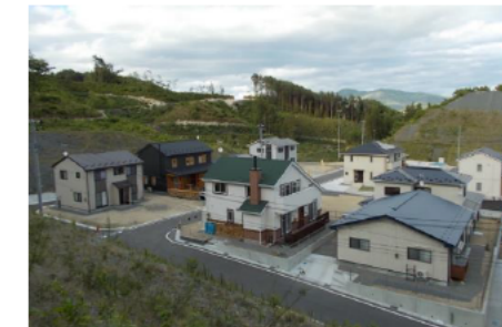
高台移転 (岩手県宮古市)
