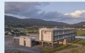
宿泊施設外観 （陸前高田市）
