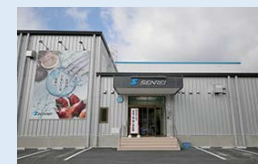
水産加工場外観 （女川町）
