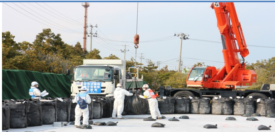
保管場への搬入・定置作業
