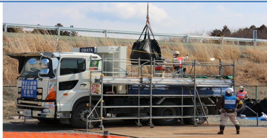
仮置場からの搬出作業
