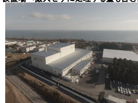
大熊町の仮設焼却施設
