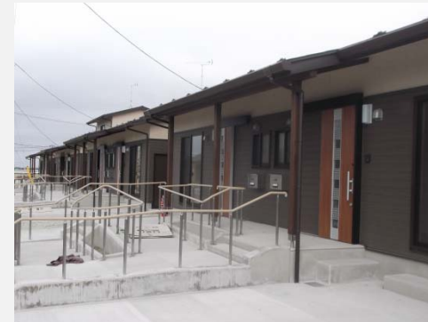
(災害公営住宅) 宮城県山元町新山下駅周辺地区
