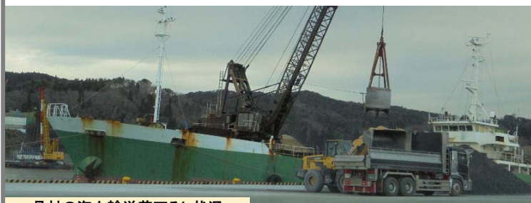
骨材の海上輸送荷下ろし状況
