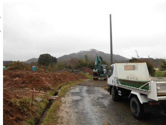
工事の始まった防集（浦の浜地区）
