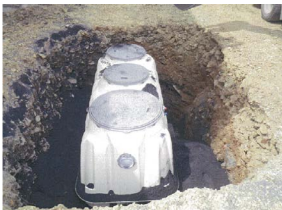
住宅再建の中で低炭素社会対応型浄化槽の設置が進む。
