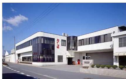
福島県いわき市にある本社工場
