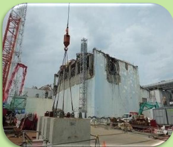
ガレキ撤去、除染
