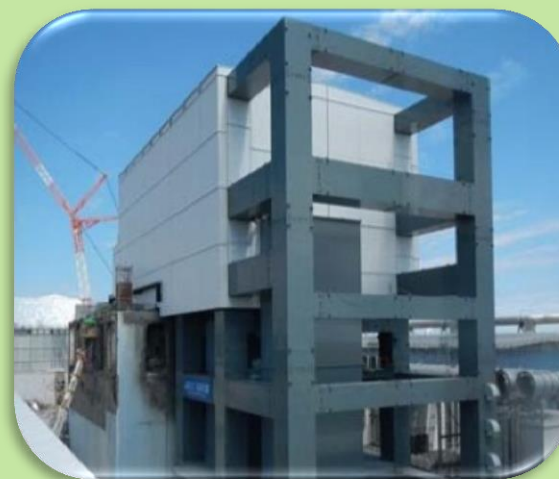
取り出しカバー設置
