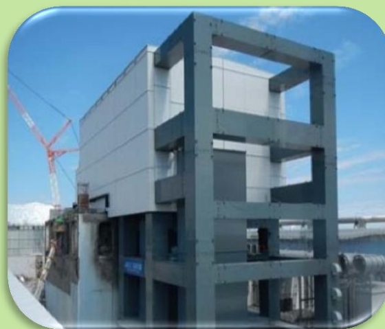
取り出しカバー設置
