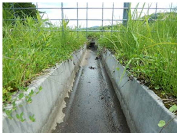
侵入口となりやすい側溝
