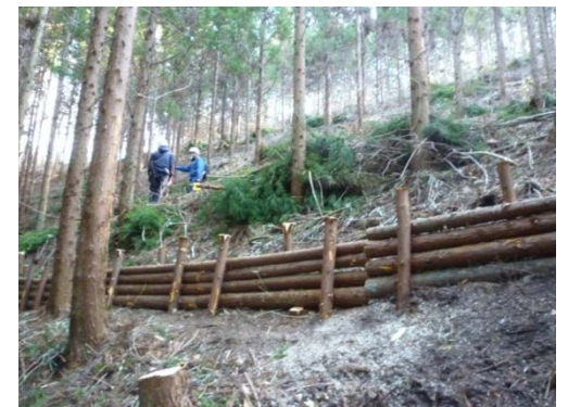
土砂流出抑制のため、木柵工を設置 (写真:福島県有林(鮫川村))
