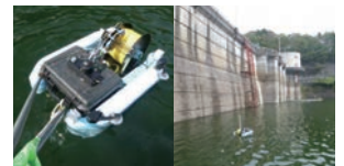
■水中ロボによるダム堤体の調査
