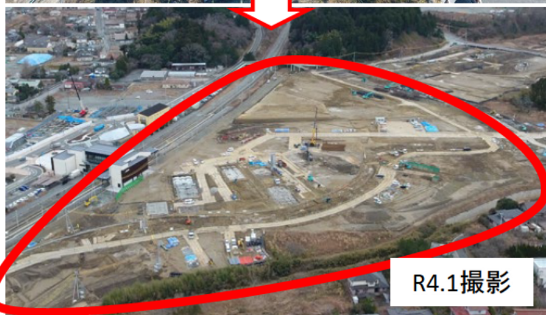
双葉駅西側地区の造成状況
