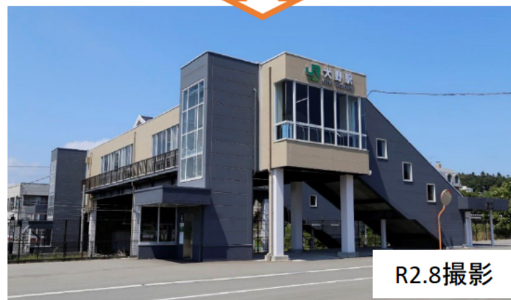
大野駅(大熊町)の復旧
