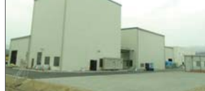
県北浄化センター 仮設汚泥乾燥施設
