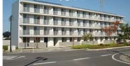
県営日和田団地 (H26.10.30完成)
