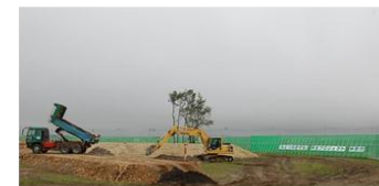
植生基盤の復旧
