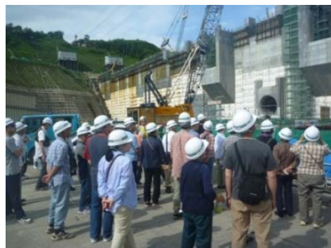
▲上流側から見る最盛期の 津軽ダムゲート工事見学
