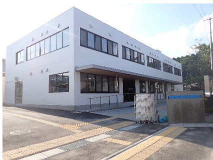
現在の施設は令和5(2023)年9月に開所した。
