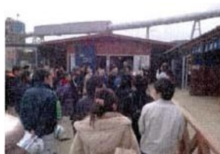
陸前高田市内の高台造成、かさ上げ工事用の巨大ベルトコンベアを案内（平成 27 年 1 月 16 日）
