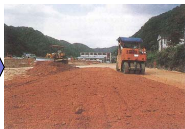
ブルドーザによる敷均し、タイヤローラーによる締固め作業
