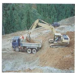
バックホウによる掘削・積み込み作業
