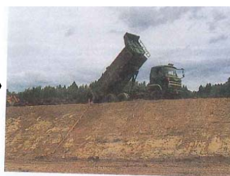
ダンプトラックによる排出作業
