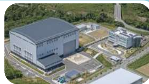
楢葉遠隔技術開発センター
