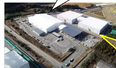
受入・分別施設 外観(大熊町)
