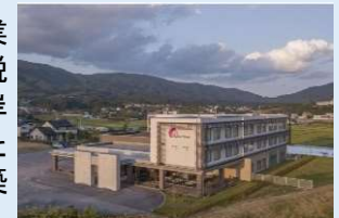
宿泊施設外観 （陸前高田市）
