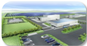
再エネ由来大規模水素製造実証拠点（浪江町）
