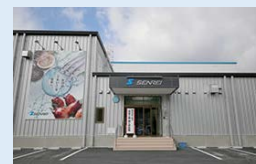
水産加工場外観 (女川町)
