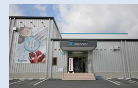
水産加工場外観 (女川町)
