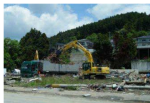
【被災家屋の解体・撤去】
