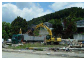
【被災家屋の解体・撤去】
