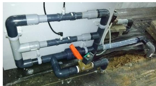
マイクロバブルノズル敷設工事後の写真
