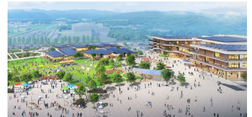
産業交流施設（CREVAおおくま） 商業施設（クマSUNテラス）
