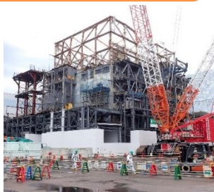
1号機の大型カバー設置の様子
