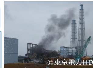
水素爆発を起こした直後の3号機
