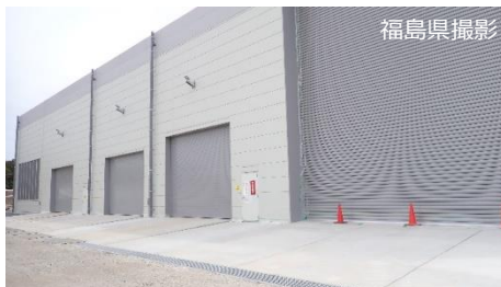
減容処理設備の外観
