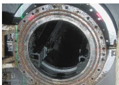
2号機 原子炉格納容器貫通孔の堆積物の除去後 （©IRID）
