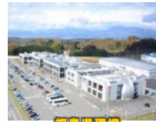
福島県環境創造センター
