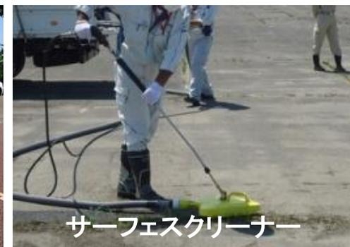
汚水をその場で回収、ろ過・循環し、洗浄用に再利用する、高圧水洗浄・循環ろ過システム(最大20MPa)で舗装面を除染。
