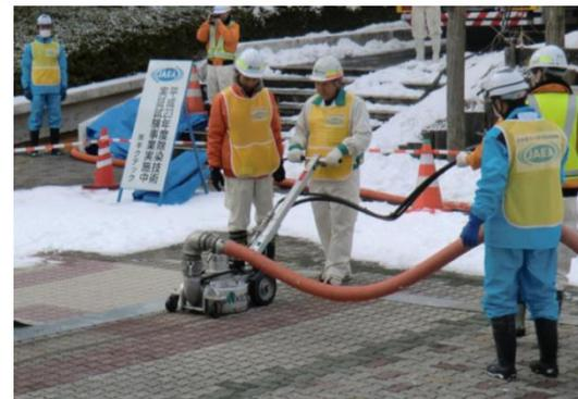
超高圧(最大280MPa)水により、汚染された舗装面を除染。
