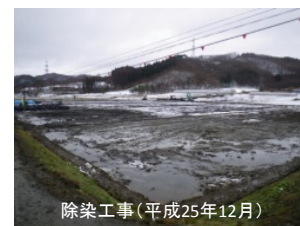
除染工事(平成25年12月)
