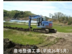
農地整備工事(平成26年5月)
