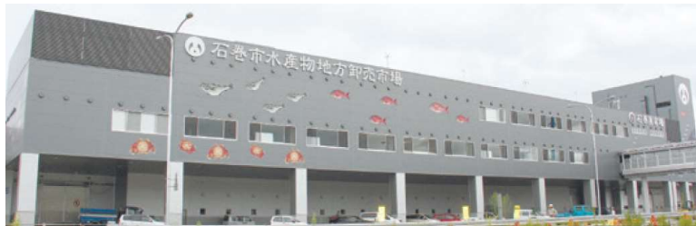
石巻魚市場（平成27年9月完成）
