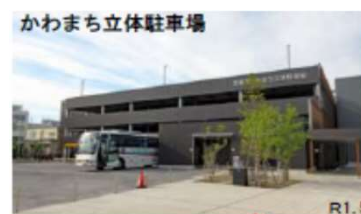
かわまち立体駐車場
