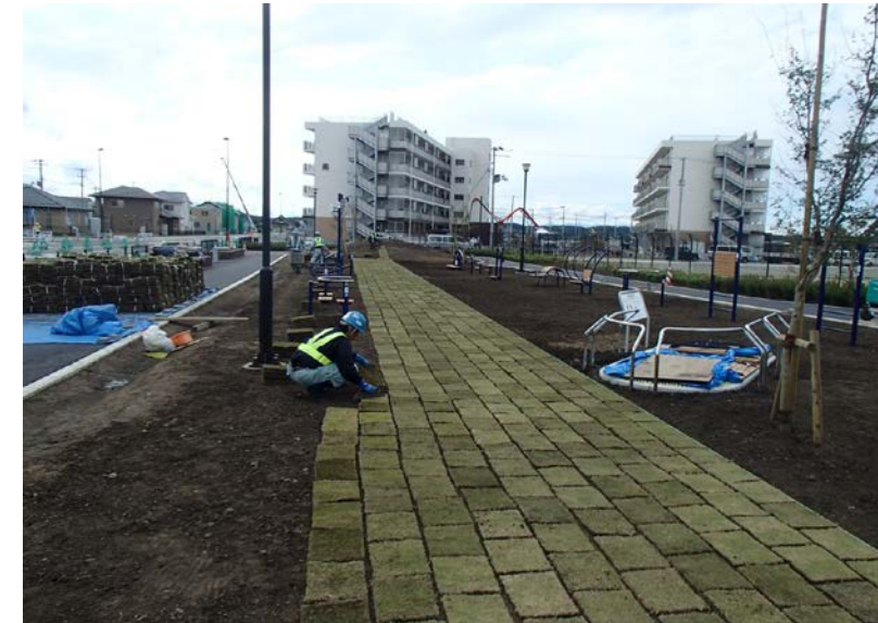
写真③ 2号公園 芝張り状況
