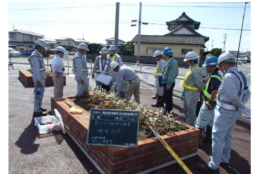
写真④ 第9次指定部分検査
