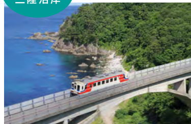
リアス海岸を眺められる大沢橋梁(おおさわきょうりょう)など絶景ポイントも多い
