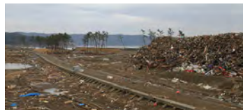
駅舎や橋梁、線路など317カ所が甚大な被害を受けた
